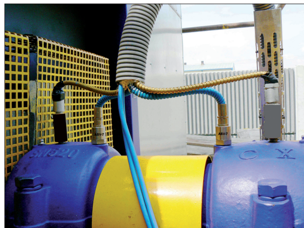
Obr. 2. Vibrační spínače ASV-7 instalované na stroji
