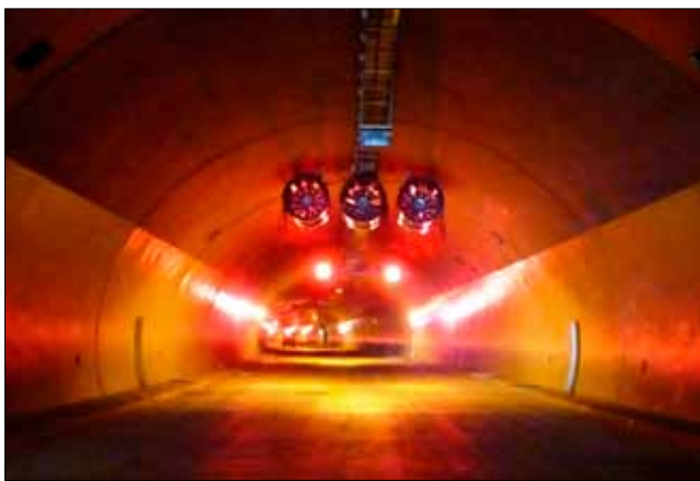
Obr. 1. Správná funkce proudových ventilátorů může výrazně ovlivnit následky požárů v silničních tunelech
